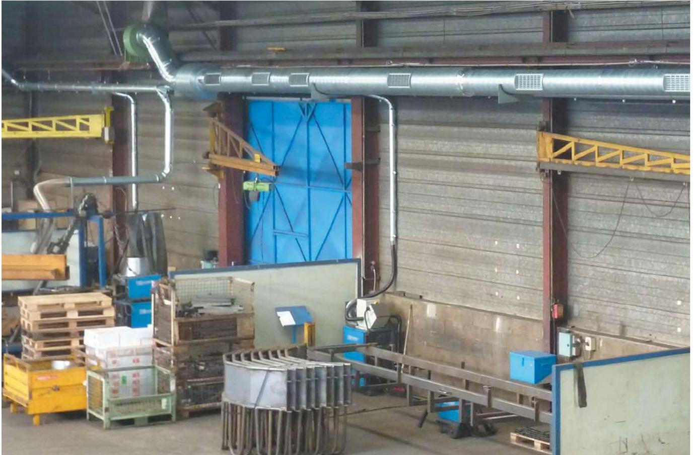
Exemple d'un système de soufflage et d'extraction :
