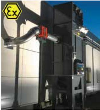
Pour un rejet d'air épuré, des centrales basse dépression **ENGMAR** peuvent être installées. Celles-ci sont dotées d'une préchambre de décantation et sont adaptées aux poussières métalliques. Les poussières décantent dans le caisson d'air sale avant de passer au travers des cartouches dotées d'un média filtrant adapté à l'application. Les installations sont dimensionnées à la demande selon votre besoin. Des filtres certifiés ATEX sont également disponibles.
