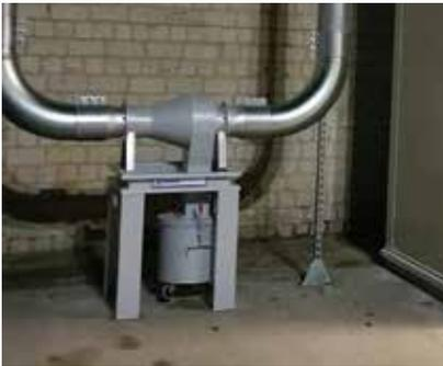
Le pare-étincelle cyclonique permet de retenir toutes les particules « lourdes » avant filtration ainsi que toutes poussières en fusion en créant une chute de vitesse soudaine et un mouvement cyclonique. Il est constitué d'un châssis métallique supportant le cyclone et d'un seau de récupération à roulettes.
