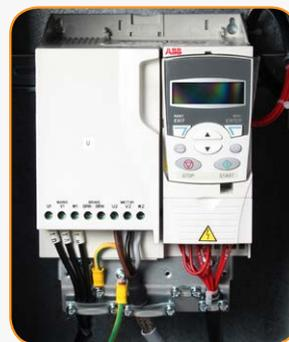
La technologie INVERTER autorise une économie d'énergie de l'ordre de 25%. La console détachable affiche les paramètres du variateur : vitesse, fréquence ou consommation moteur (kW).
